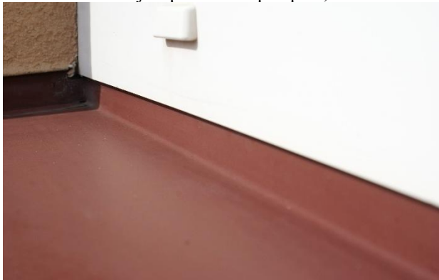
Obr. č. 5: Vnější oplechování parapetu, detail rohu
