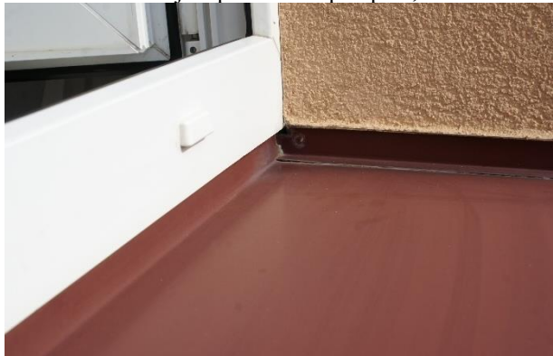
Obr. č. 6: Vnější oplechování parapetu, roh
